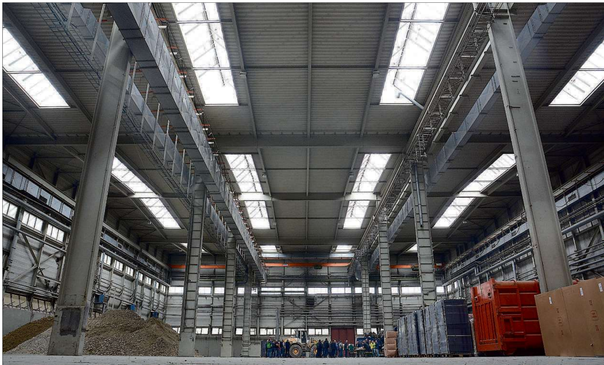
Doch, hier passt einiges an Altpapier rein: Die Riesenhalle im Dusslinger Müllbetrieb könnte dem Landkreis als Umschlagplatz dienen. Im Hintergrund inspizieren Fachleute die mögliche Station. Bild: Rippmann
